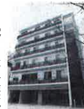
（呉市西中央4-6-3、平尾清史社長）は4月1日、同市中央3-1-22に複合介護施設「ケアビレッジすまいる呉中央」をオープンする。敷地面積492平方メートルに、6階建て延べ1999・95平方メートルのケアモビルを新設。1階に既設の居宅介護事業所のほか、訪問介護事業所、福祉用具のレンタル・販売、ケアワーカー（家政婦）紹介事業所を近隣の自社ビルから移設。2・4階に定員20人のデイサービスセンター（年内申請予定）と29人のショートステイを置く。5・6階は12部屋のサービ
